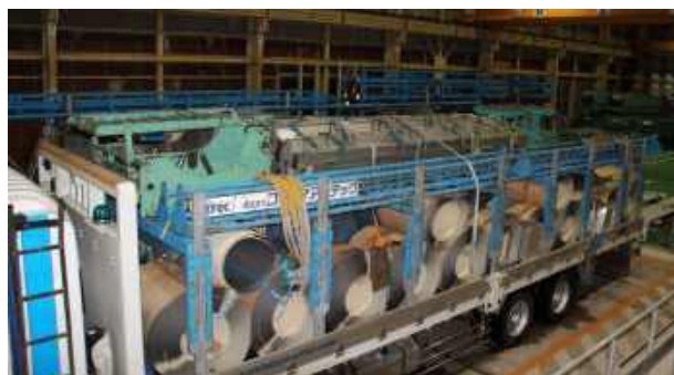
現場加工（成型機・アンコイラー・天秤）積載
